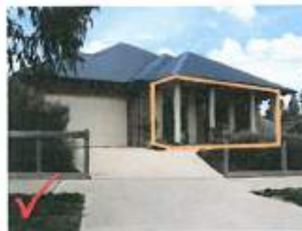
Portico or Verandah
